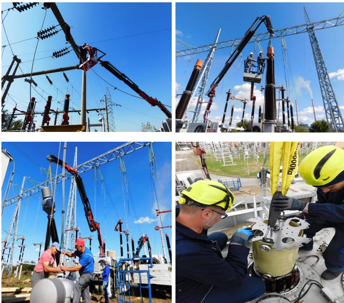
Слика 16. Монтажа на опрема во трансформаторски станици
